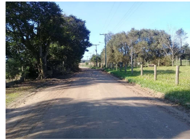
IMAGEM 06 - ESTACA 20+00 - REMOÇÃO DE ÁRVORES
