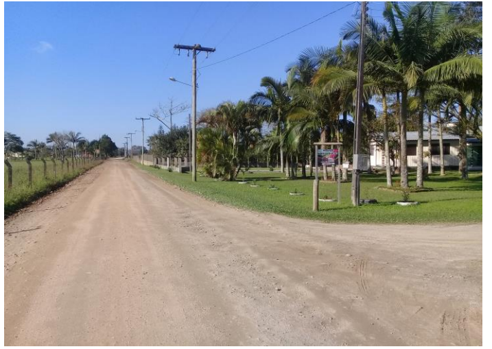
IMAGEM 10 - ROD. A SER PAVIMENTADA
