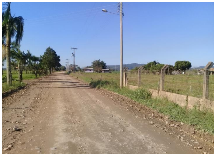
IMAGEM 12 - FINAL DA PAVIMENTAÇÃO
