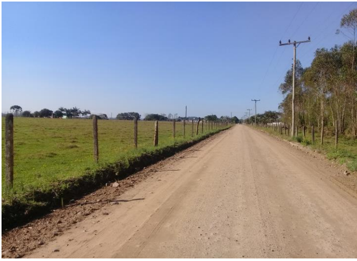
IMAGEM 07 - ROD. A SER PAVIMENTADA
