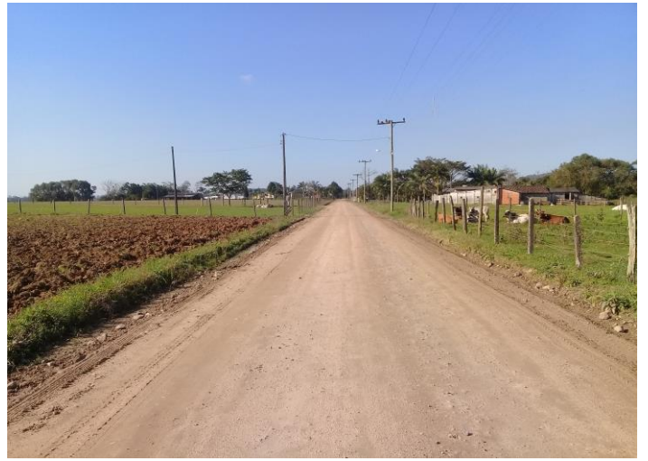
IMAGEM 08 - ROD. A SER PAVIMENTADA
