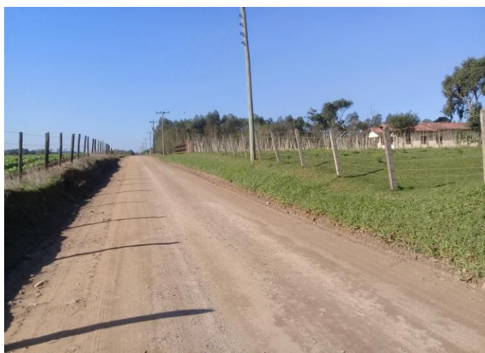
IMAGEM 03 - ROD. A SER PAVIMENTADA
