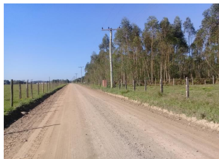
IMAGEM 06 - ROD. A SER PAVIMENTADA
