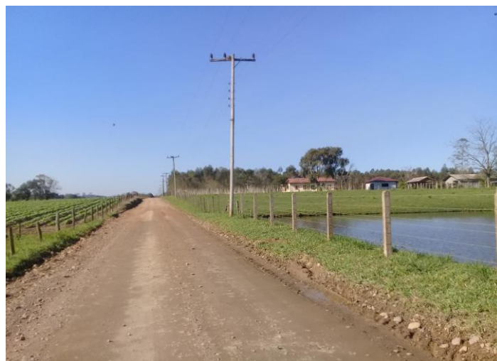
IMAGEM 02 - ROD. A SER PAVIMENTADA
