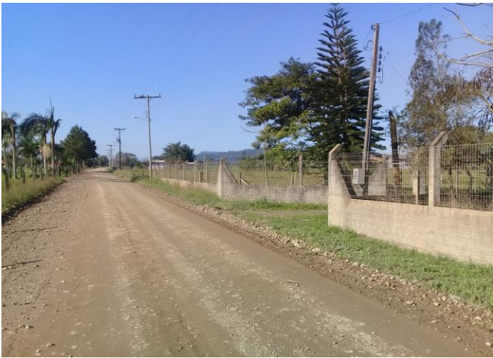
IMAGEM 11 - ROD. A SER PAVIMENTADA
