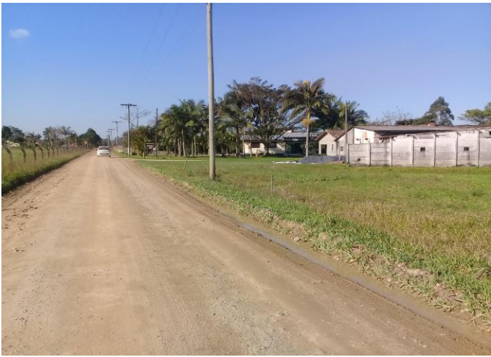
IMAGEM 09 - ROD. A SER PAVIMENTADA
