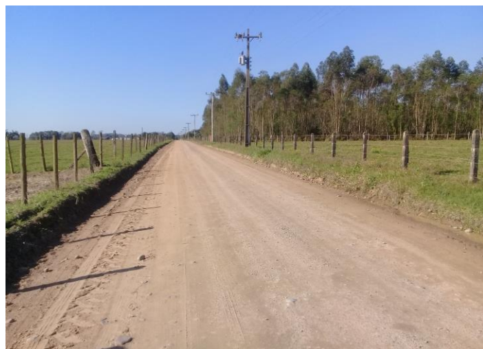
IMAGEM 05 - ROD. A SER PAVIMENTADA
