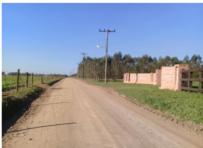
IMAGEM 04 - ROD. A SER PAVIMENTADA
